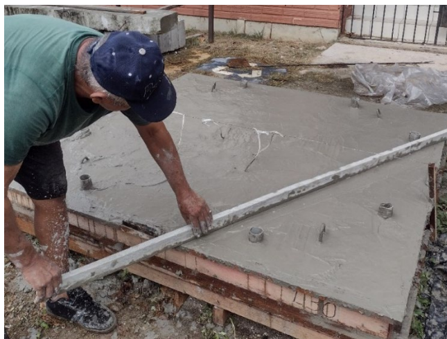
Figura 3.8 – Regularização da superfície das lajes.
