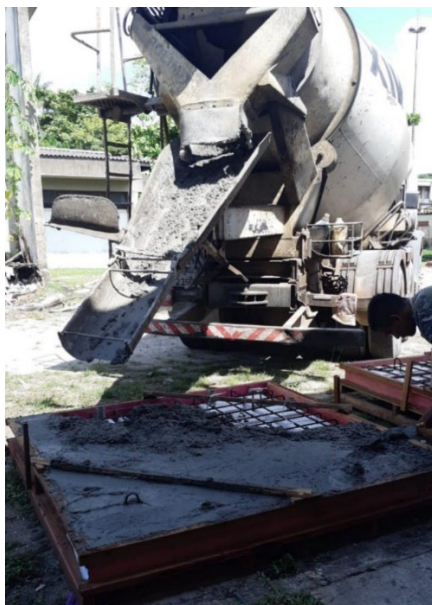
Figura 3.7 – Lançamento do concreto.
