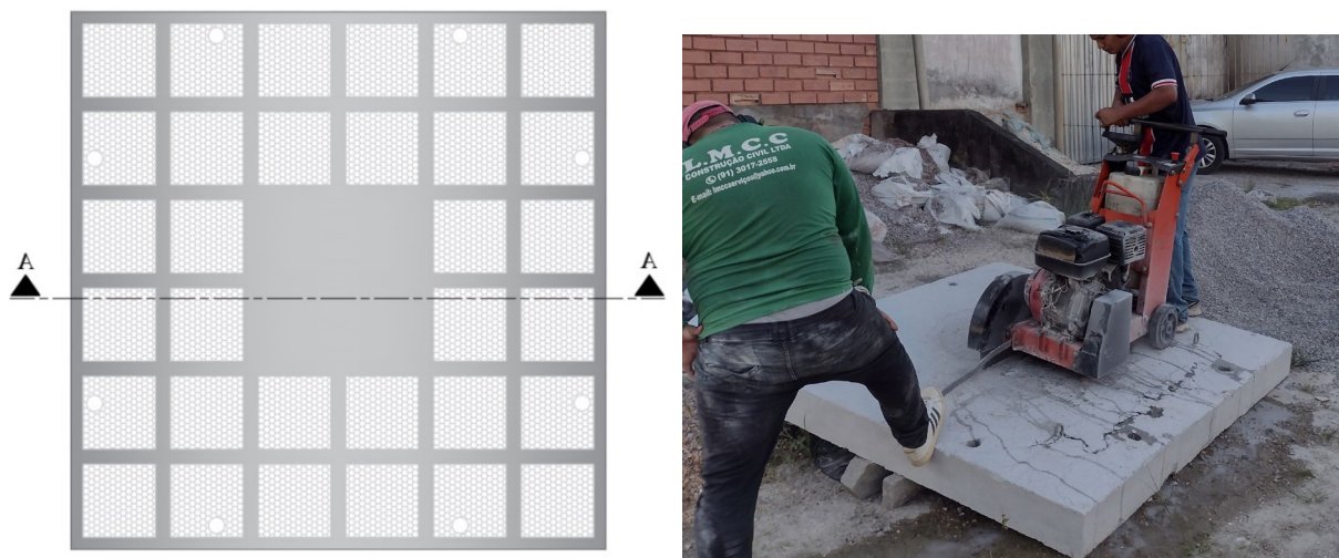
Figura 4.3 – Plano e processo de corte das lajes.
